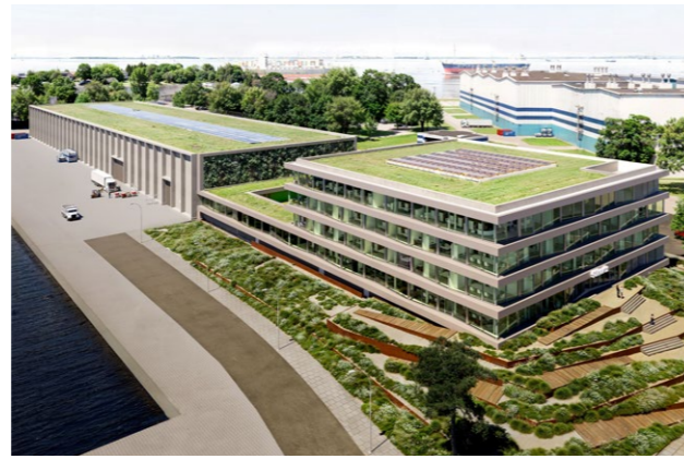
Zukünftige Niederlassung 50Hertz: Rostocker Offshore Quartier
